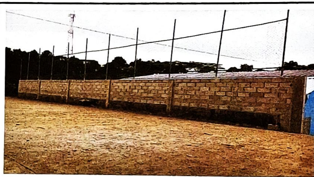
Foto 4: Ampliación del muro perimetral que cubre el primer módulo
