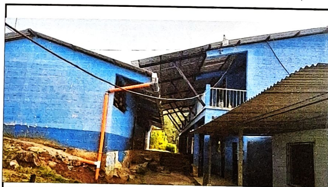
Foto 6: Instalación de vigas y techo del pasillo del primer módulo
