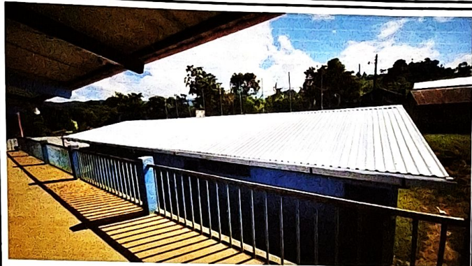
Foto 1: Sustrucción de lamina en mal estado por lamina troquelada en aulas.
